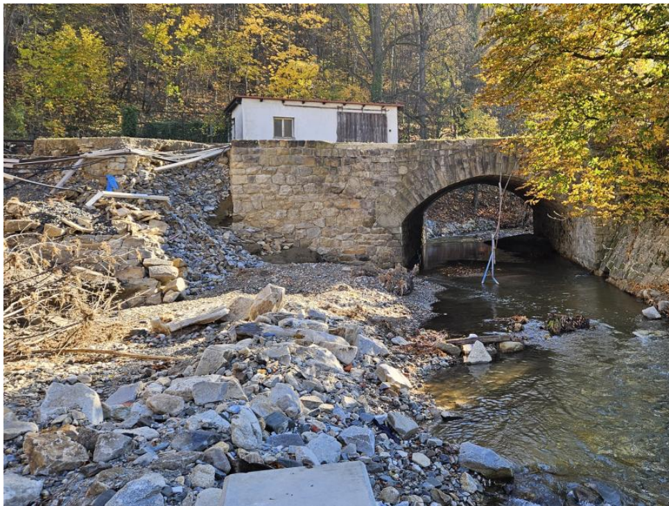
Obrázek 1. Zničené navazující křídlo na levé straně opěry O2
