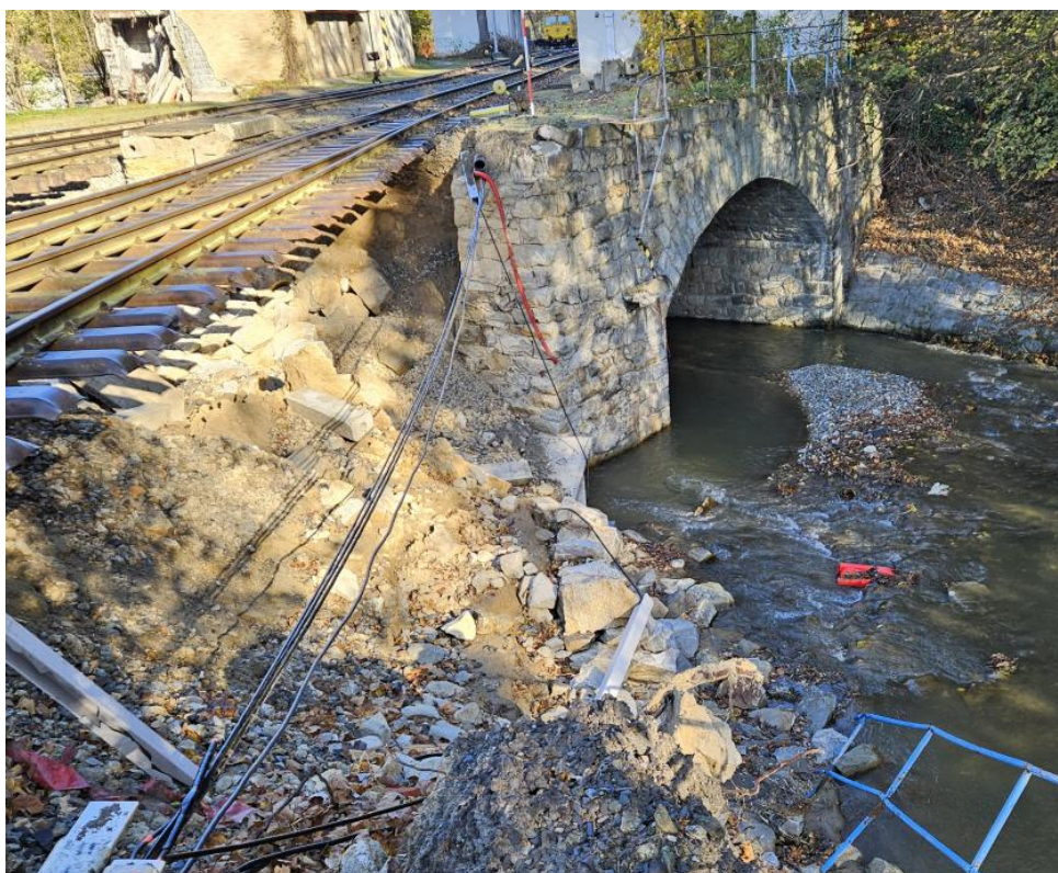
Obrázek 2. Odplavené křídlo na pravé straně opěry O1
